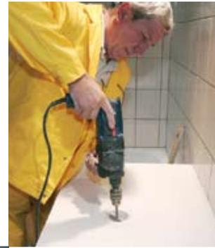
In die Plattenmitte wird anschließend das Loch für die Durchführung der Ablaufgarnitur gebohrt.
