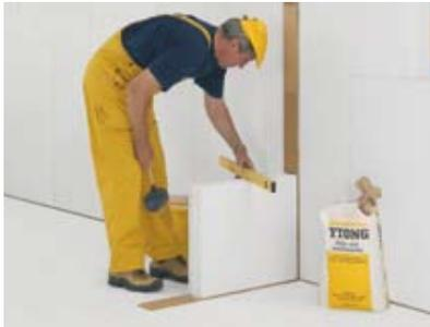
Danach wird die erste Schar YTONG Zwischenwandplatten fluchtgerecht in ein Mörtelbett (Konsistenz 9-9,5 l Wasser pro Sack) aufgesetzt.
