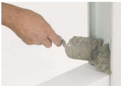
YTONG Setz- und Verfüllmörtel im Bereich der horizontalen Mörtelfuge auftragen. Ebenso wird die Feder der Stoßfuge der zu versetzenden Zwischenwandplatte mit Mörtel versehen, versetzt und lot- und fluchtgleich ausgerichtet.
