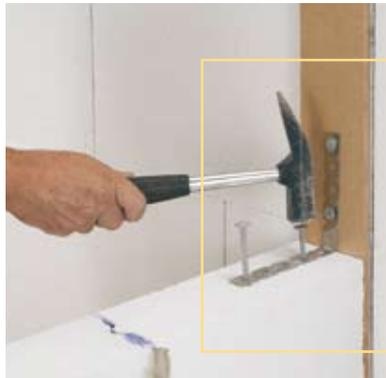
Anschlüsse sind anzuwenden, um Kräfteinleitungen in nichttragende Wände durch Verformung der bestehenden Bauteile weitgehend einzuschränken und werden durch Anordnung von Profilen, Nuten oder Winkellaschen hergestellt.
