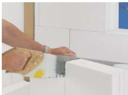
**Mit einer Widiäsäge lassen sich YTONG Steine einfach und schnell bearbeiten.**
