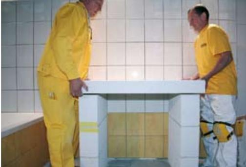
Die fertig aufgemauerten Seitenwände werden anschließend mit der Tischplatte verklebt.
