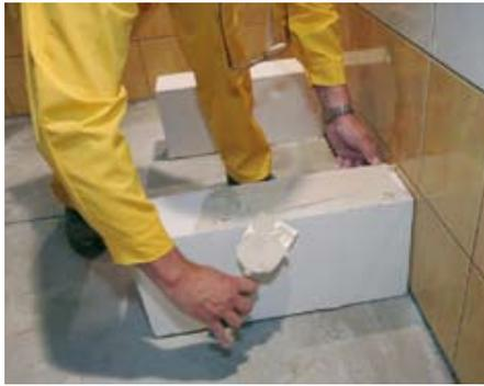
YTONG Plansteine (z.B. 10 cm Dicke) auf gewünschtes Maß kürzen und waagrecht auf die Bodenkonstruktion aufsetzen.
