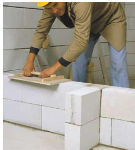
**Nichttragende Zwischenwände werden genauso wie tragende Innen- und Außenwände immer im Verbund gemauert.**
