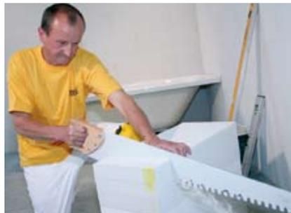
Die YTONG Plansteine (z.B. 7,5 cm Dicke) werden auf das erforderliche Maß mit einer Widasäge zugeschnitten.
