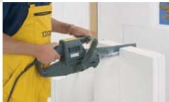
Aus den feinporigen Vollsteinen lassen sich Passstücke mit der YTONG Alligatorsäge (Bild) oder Handsäge exakt zuschneiden.
