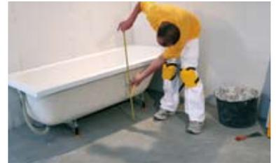
Beim Maß nehmen an der waagrecht eingeregneten Badewanne muss die Mörtelfuge berücksichtigt werden. Für eine bessere Schallentkopplung können Dämmstreifen am Boden- und Wandanschluss angebracht werden. Gleiches gilt für Vermauerung von Duschtassen.
