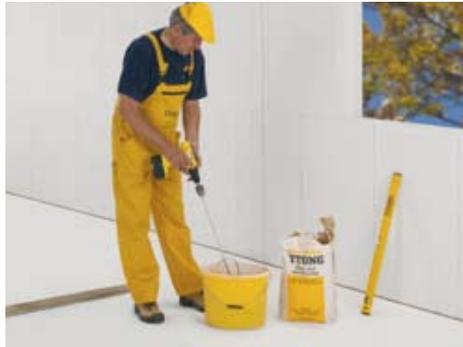
**Niveausgleich (bei Bedarf):** YTONG Setz- und Verfüllmörtel für den Niveausgleich in dickerer Konsistenz (8-8,5 l Wasser pro 25 kg Sack) mit dem Quirl anrühren, auf Untergrund aufmörteln, waagrecht abziehen, Dämmstreifen auflegen und ansteifen lassen.
