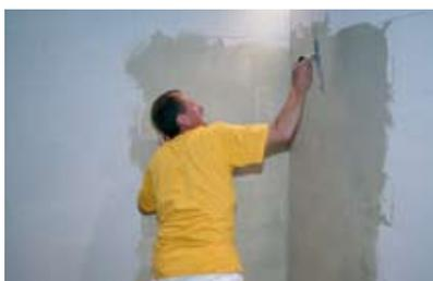
Im Duschbereich wird das YTONG Mauerwerk mit entsprechenden Produkten gegen Feuchtigkeit geschützt.
