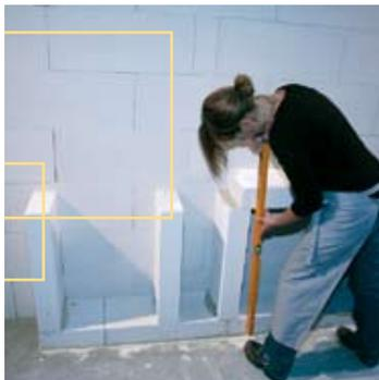
Als ersten Schritt eine Skizze anfertigen, wie das Regal am Ende aussehen soll (Steinmaß von YTONG berücksichtigen). Anschließend werden die Plansteine waag- und lotrecht bzw. mit dem Mauerwerk verklebt.
